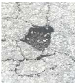
图4-26 水结冰后膨胀使路面形成洞坑
